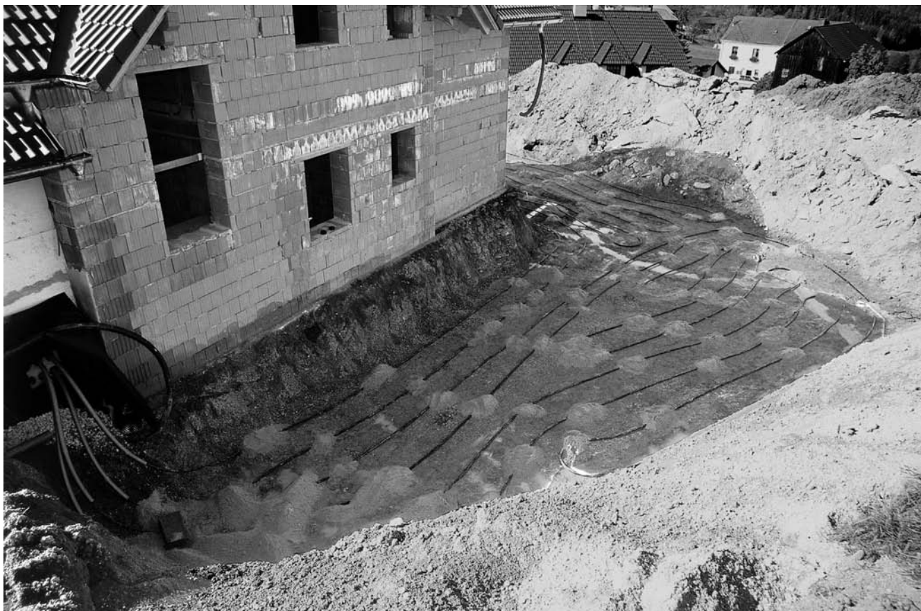
Collettore di terra prima della posa nel letto di sabbia
